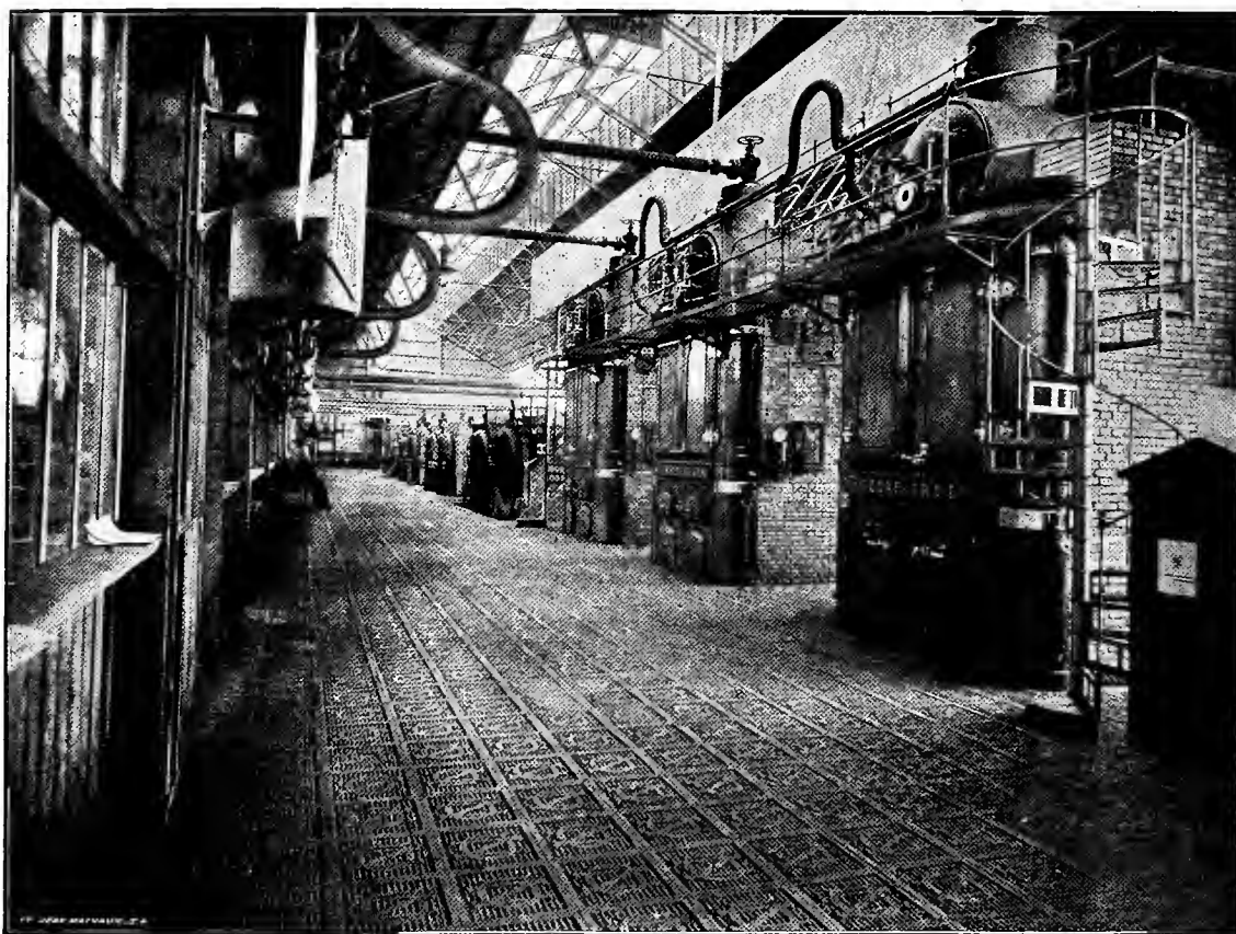
LE HALL DES CHAUDIÈRES.
